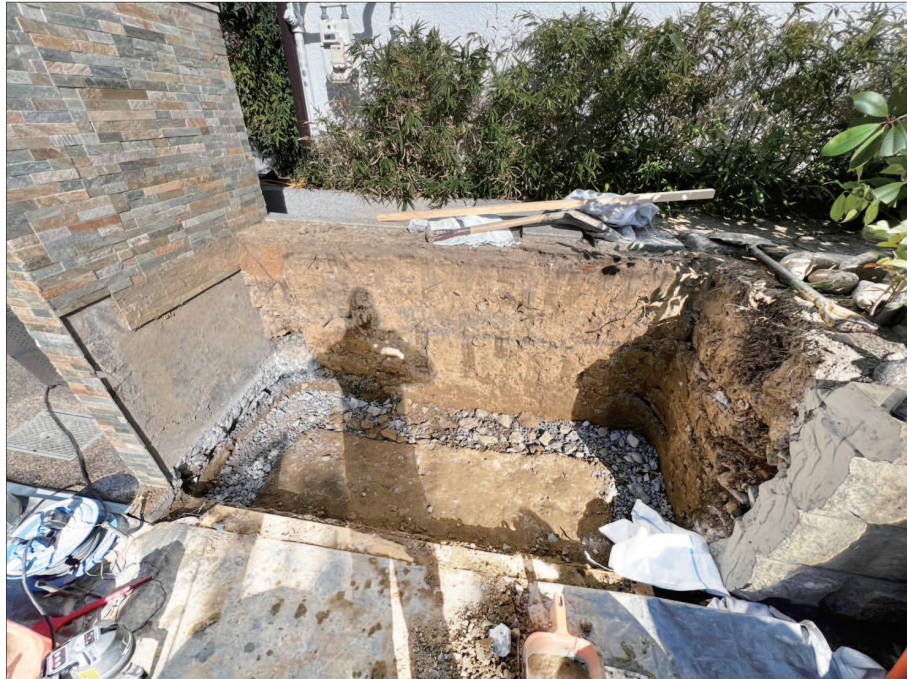
植木・残土の撤去完了
