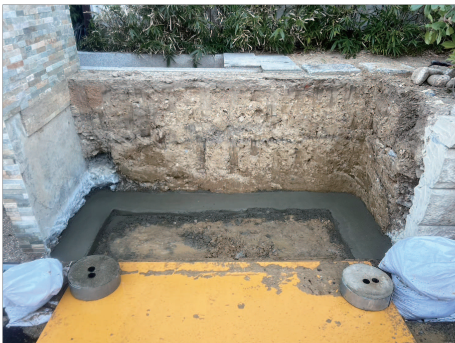
基礎(ベースモルタル)作り
