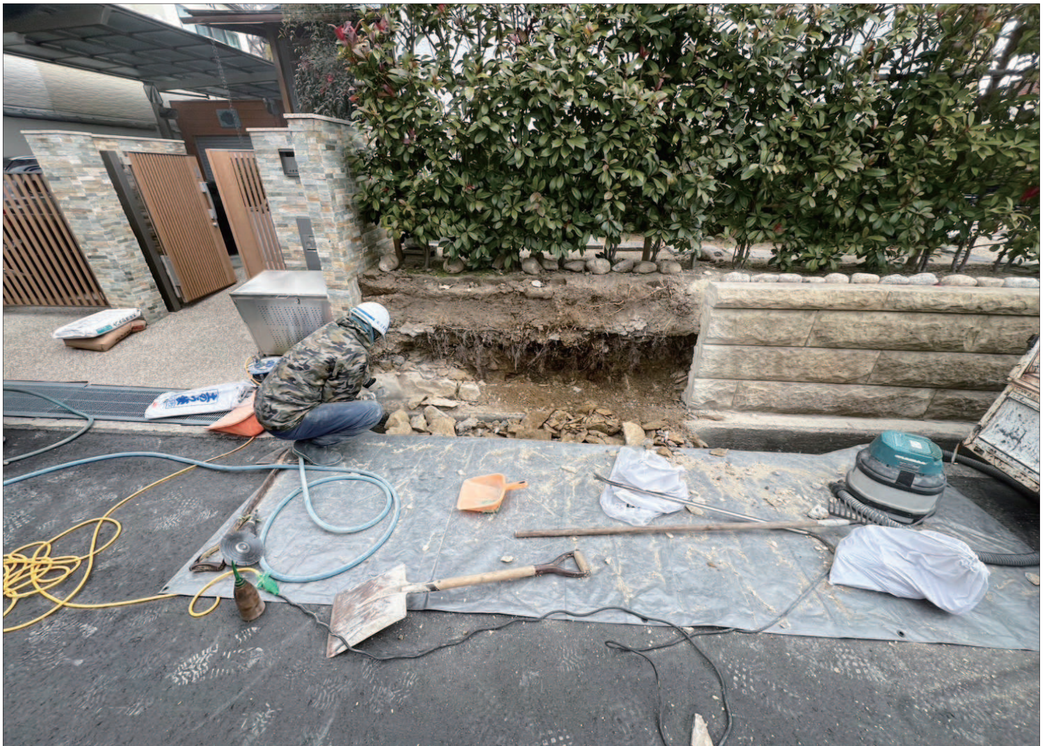
既存 石塀の解体・撤去
